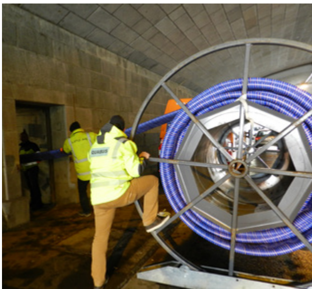
Bild 1 und Bild 2: Nach dem Einzug des Windenseils wurde der Primusline® montiert und über die ganze Länge in die Leitung eingezogen
