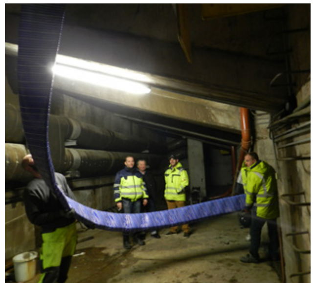
Bild 1 und Bild 2: Nach dem Einzug des Windenseils wurde der Primusline® montiert und über die ganze Länge in die Leitung eingezogen
