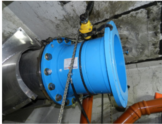
Bild 4: Übergangsverbinder
