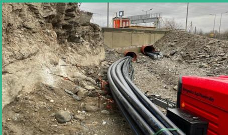
Rohrbündel mit Spillwinde
