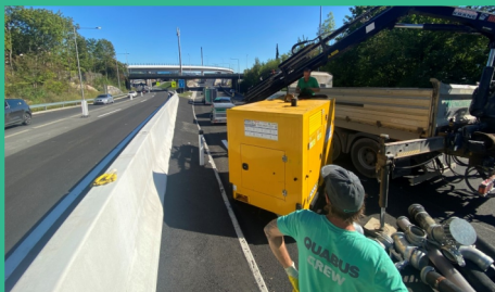
Baustelle Autobahn A7
