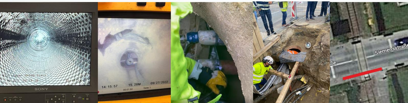
Nach erfolgter Reinigung und Kontrolle mittels TV Inspektion wurden die fertig auf die Baustelle gelieferten CarboSeal® Liner in die 2 Stahlrohre eingezogen, mit Druckluft an die Innenwand des Altbestandes gepresst und mittels Dampf ausgehärtet.
